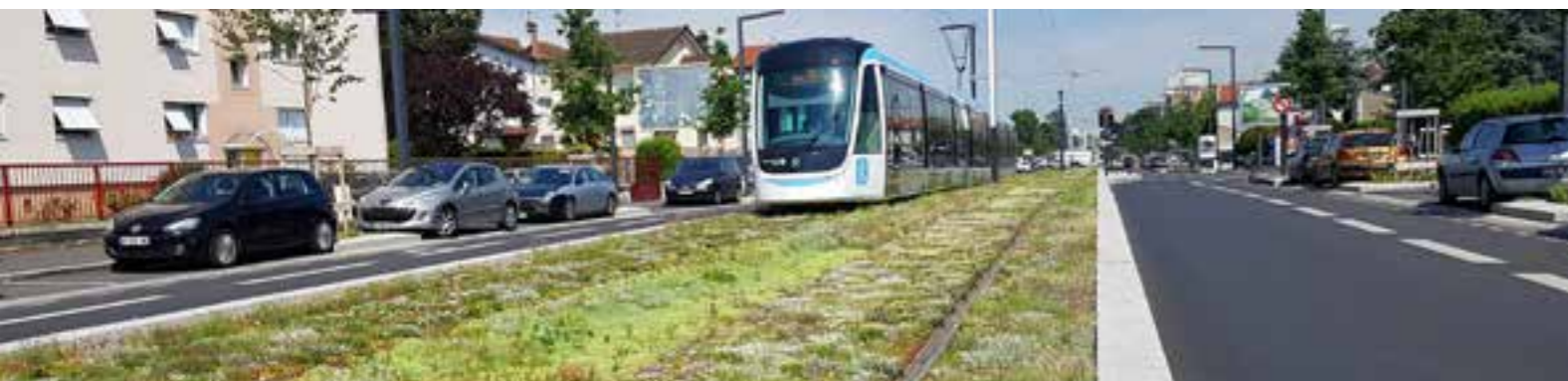
STABILISATION DE SOLS
